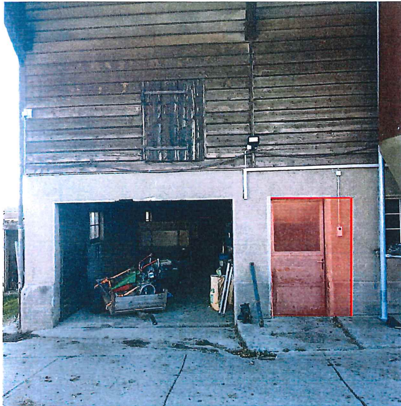
Agrandissement de la porte. Dimensions après travaux = 165cm (largeur) x 230cm (hauteur)
